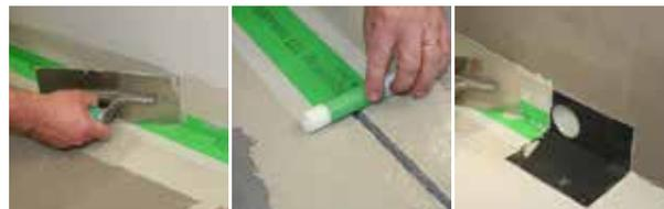
Impermeabilizzare i giunti strutturali con Aquastop 200 HP, nastro impermeabile elastico sotto-piastrelle in gomma NBR rivestito su ambo i lati da polipropilene non tessuto a elevata adesione.
